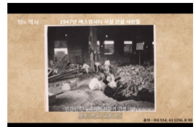
애스컴시티 시설 건설 사진 출처 : RG 554, A1 1256, B 99
